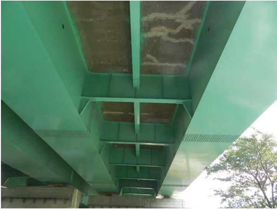
바닥판하면 및 강박스 외부전경
